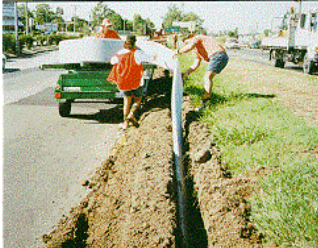
Geocomposite edge drain retrofitting
